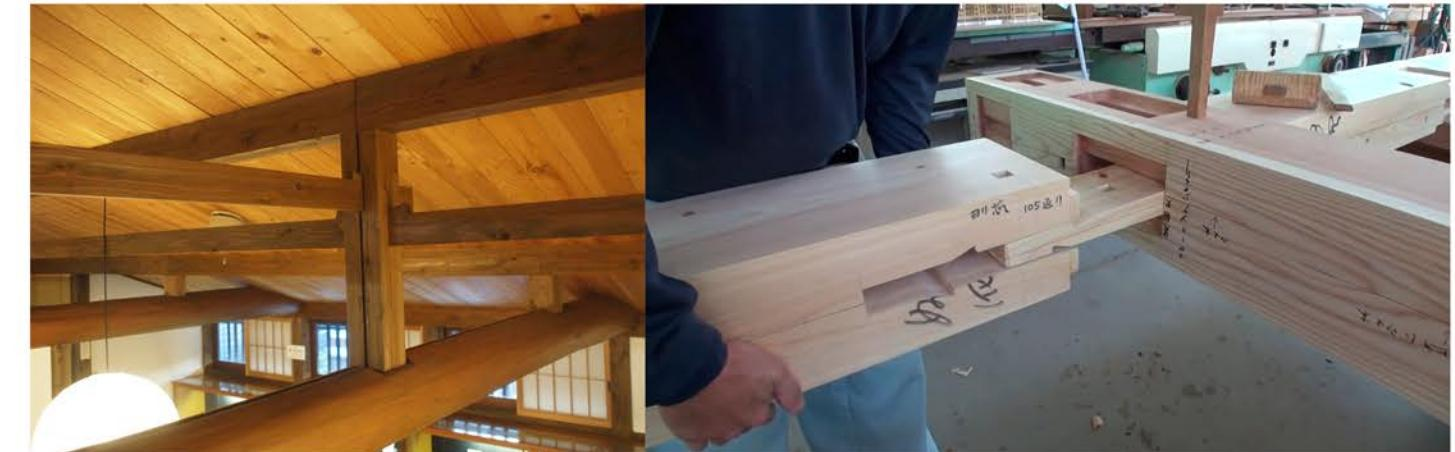
Técnica tradicional de construcción japonesa en la que no se usan clavos. Se mecanizan las piezas para lograr un anclaje perfecto entre las distintas piezas que conformarán la estructura.
